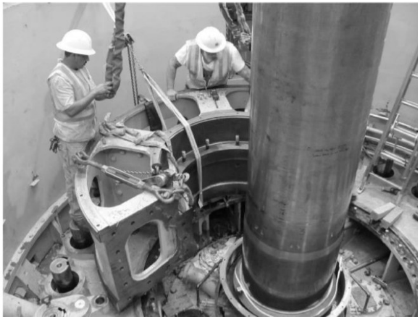
Bir hidro-elektrik santralindeki su türbininin eksenel yatağının montajı
